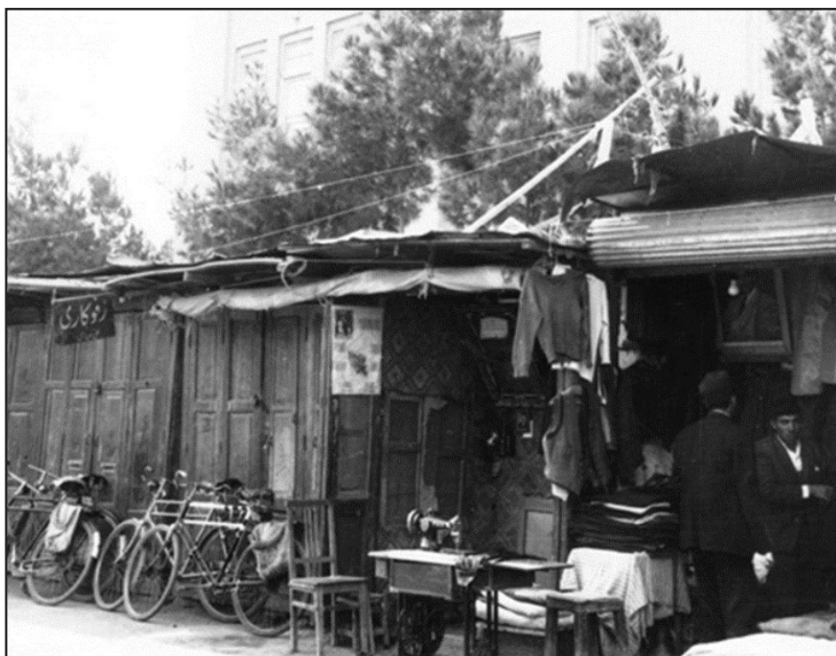
دکان‌های پشت شهرداری قسمت شمالی قبل از خرابی و
